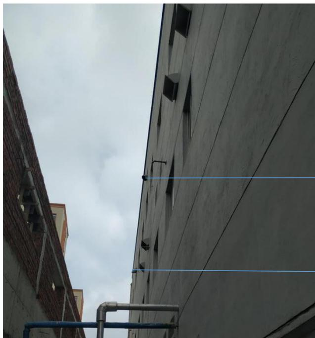
包衣机，风量 2500 m<sup>3</sup>/h。口径 320mm，离地约 18m，距楼顶约 3.5m。
