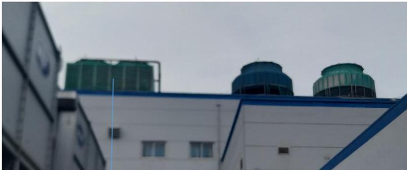
长\*宽\*高：7.8m\*5.5m\*4.3m，共 2 台风机，只开西侧风机。设备老旧，风量未知。冷却塔距南墙边缘 1 米，距东侧厂界约 23 米。
