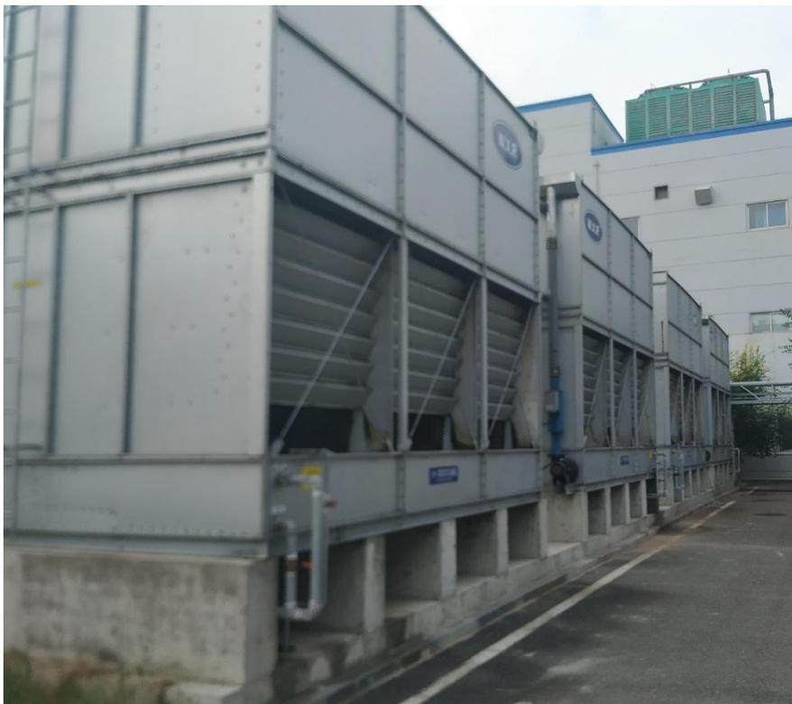
每台设备的长\*宽\*高：5.33m \*2.38m\*5.70m；4 台蒸发冷总长为 25.8m。
