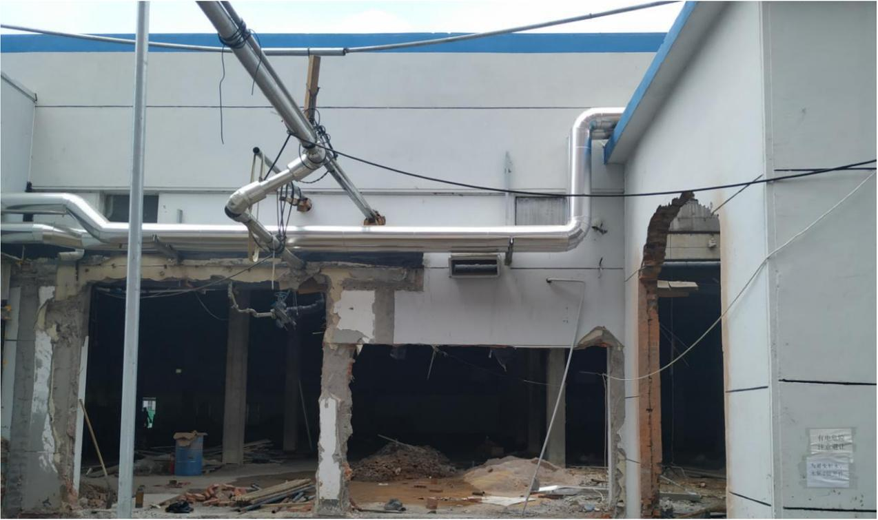
新建机械间预计增加两台风机，功率 37KW 1 台，55KW 1 台，配套相应镀锌风管。
